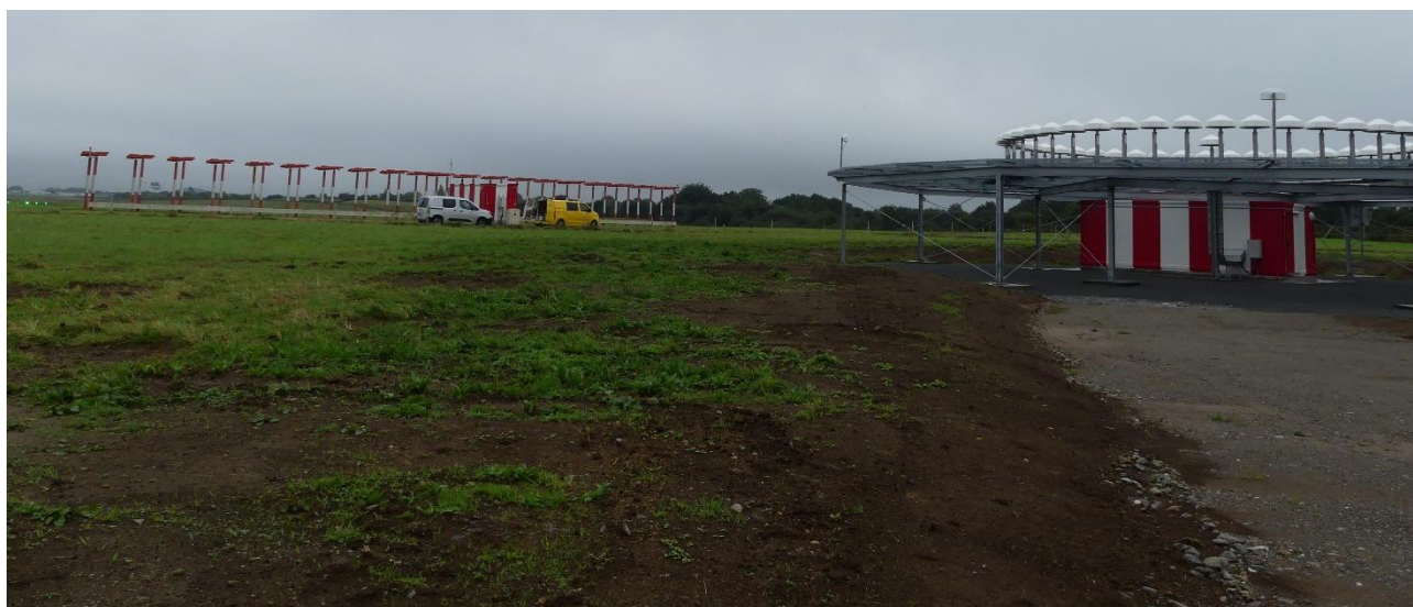
Photo 1 : Installation du VOR - FM, 09/25
