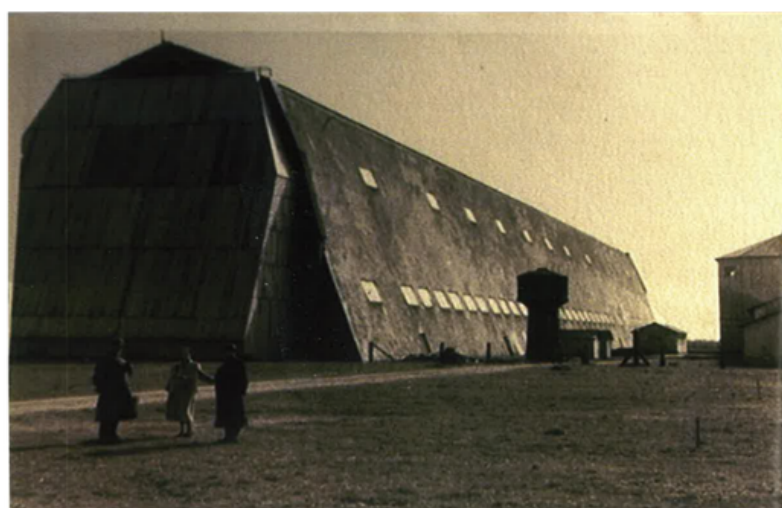
1917, plateau de Lanrus, la Marine aménage un hangar équipé d'une porte de 92 tonnes.
